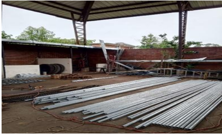
Figura 26. Área de Soldadura
