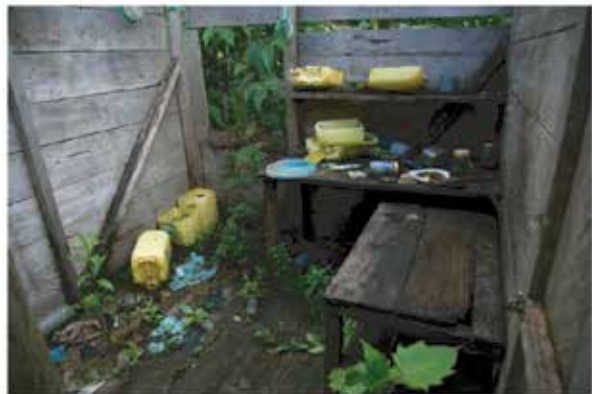
Inmensas cantidades de ropa y utensilios de cocina se quedaron en la Mina Vieja. La malaria ha invadido las precarias estructuras de madera que sirvieron como casas, comedores y bodegas. Siete plantas eléctricas obsoletas también siguen en el lugar.
