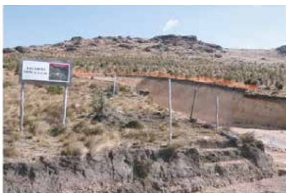
Vista de una bocanilla del proyecto Río Blanco. Foto de Stefan Paetes / La Historia
