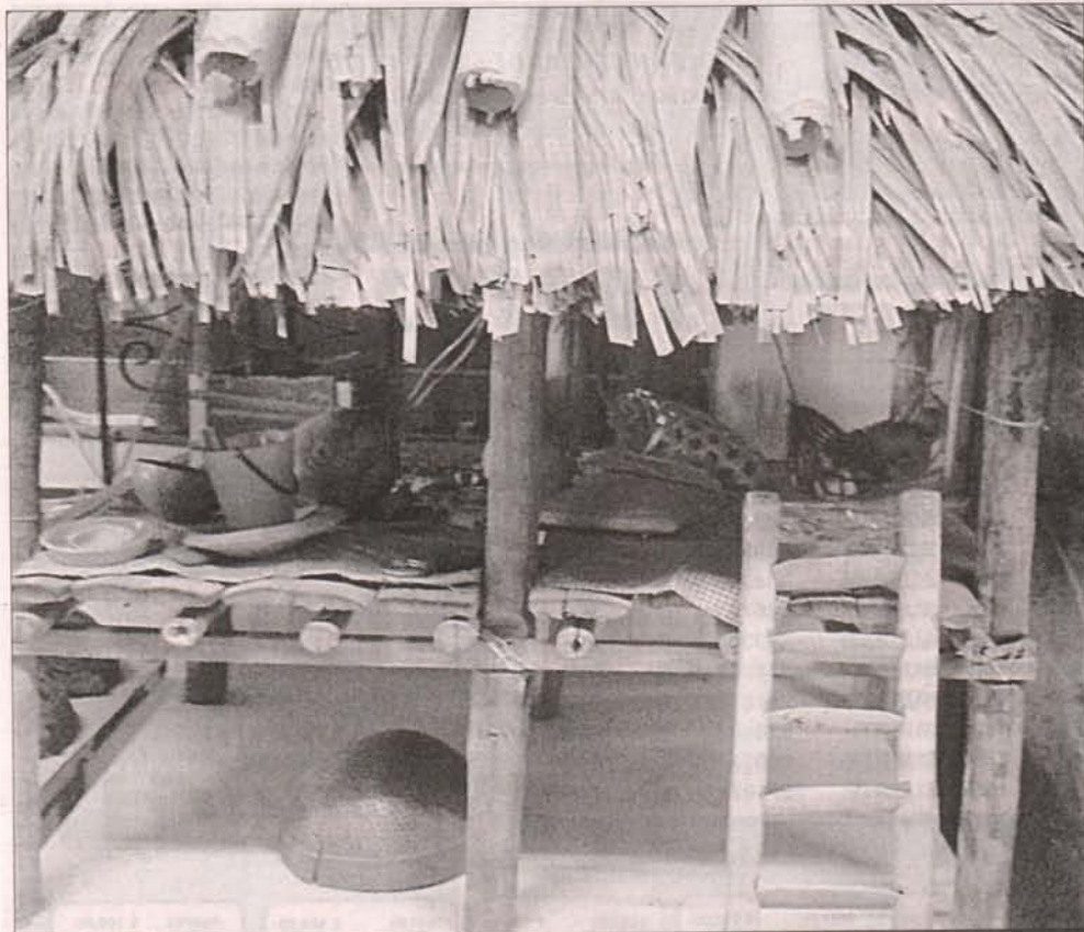
Muestra de vivienda chachi, que generalmente se construye con postes de chonta y guadúa, hojas de paja toquilla o lizán y bejucos del monte.
