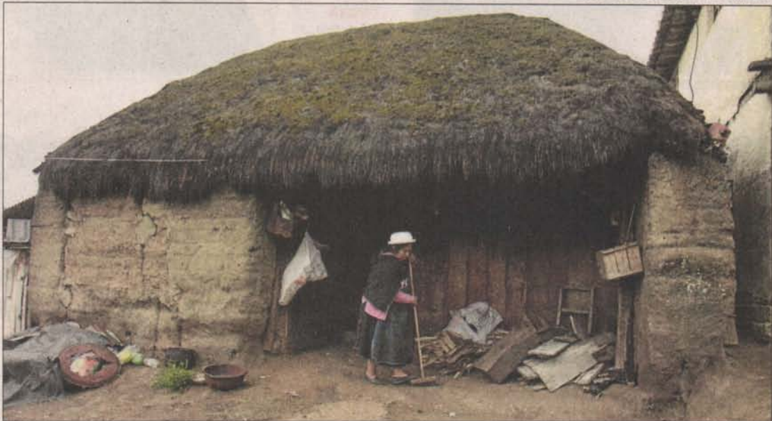
• La choza de los suegros de Tixilema está ubicada en el ingreso del barrio San Juan de Dios, de Chibuleo.
