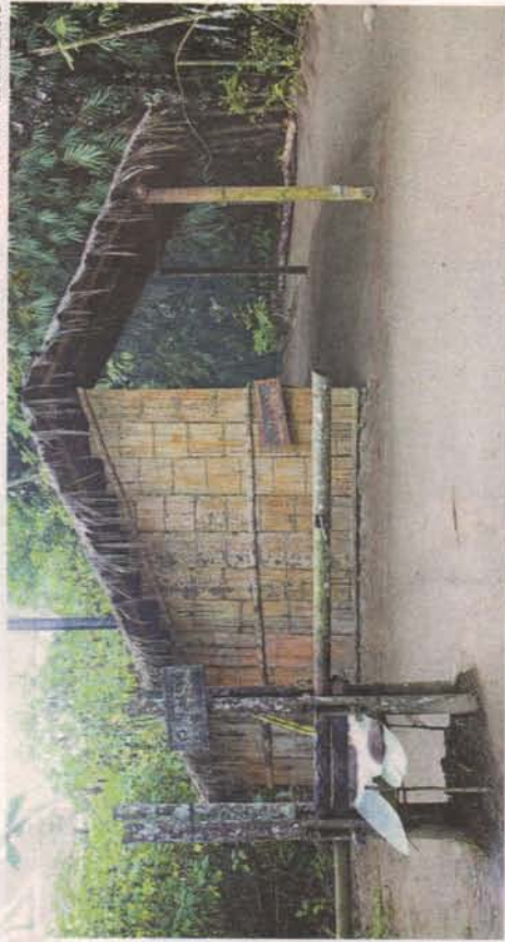
• Los materiales utilizados siguen siendo los mismos: caña guadúa, paja toquilla, pambil.
