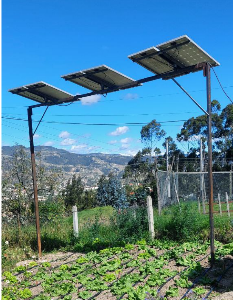
Figura 3.2: Montaje de los paneles solares.
