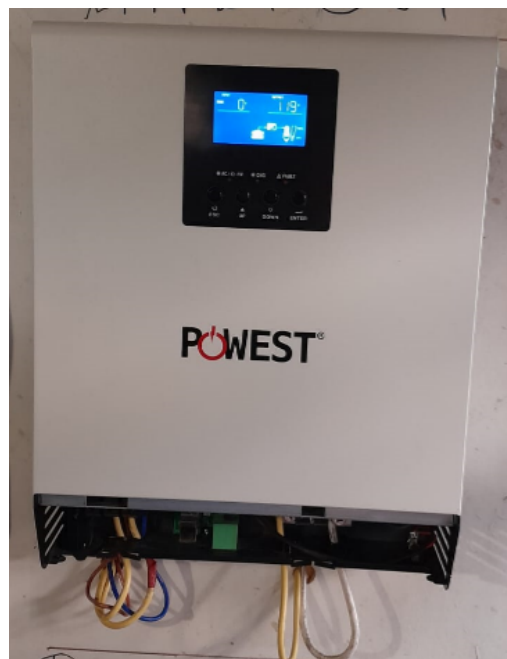
Figura 3.5: Montaje y conexión del inversor.
