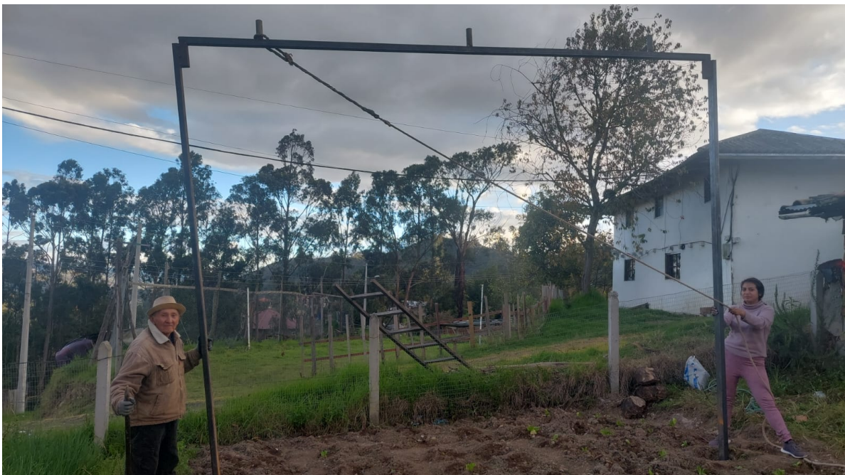
Figura 3.1: Izado de la estructura de los paneles solares.
