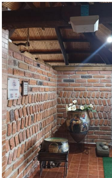
Figura 0.7 Instalación de antena para zona 4
