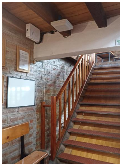
Figura 0.5 Instalación de antena para zona 2.
