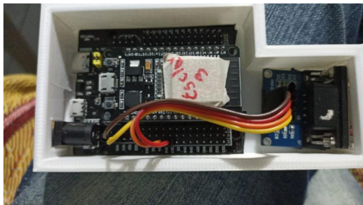
Figura 0.13 Instalación ESP32 y modulo RS232.
