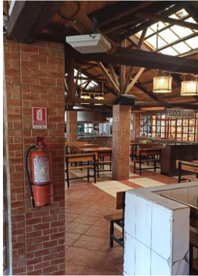
Figura 0.4 Instalación de antena para zona 1.
