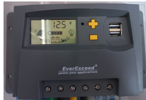
Figura 6. Regulador de carga solar Fuente: Autores
