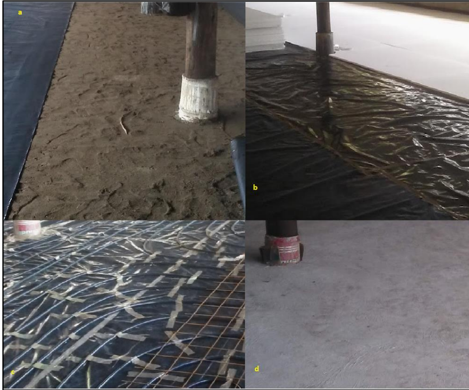
Ilustración 16.. Proceso de construcción de suelo radiante. a) Capa de arena y plástico, b) capa de poliestireno expandido, c) tubería de polietileno y malla armex.
