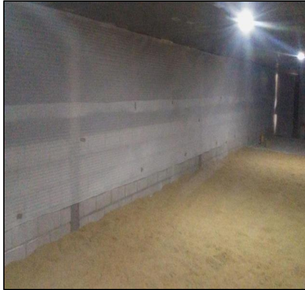
Ilustración 70. Aislamiento de las ventanas para mantener la temperatura dentro del galpón y evitar que la luz exterior entre [AUTOR].
