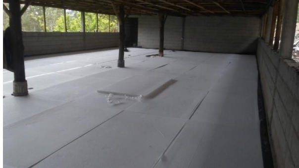
Figura A. 40. Proceso de fabricación piso radiante aislamiento [AUTOR].
