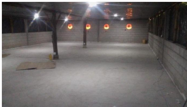
Figura A. 45 Proceso de construcción piso concreto e implementación de sistema de ventilación [AUTOR].
