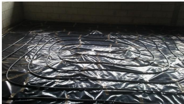
Figura A. 42 Proceso de fabricación piso radiante tuberías de agua [AUTOR].
