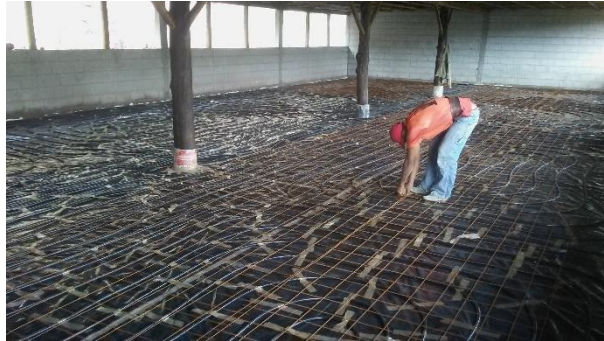
Figura A. 43. Proceso de construcción de piso radiante tuberías de recirculación. [AUTOR].
