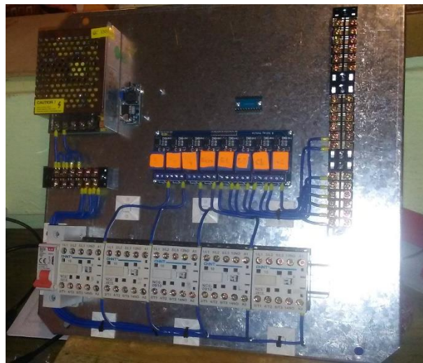
Figura A. 33 Proceso de Fabricación tablero de control, conexiones eléctricas [AUTOR].
