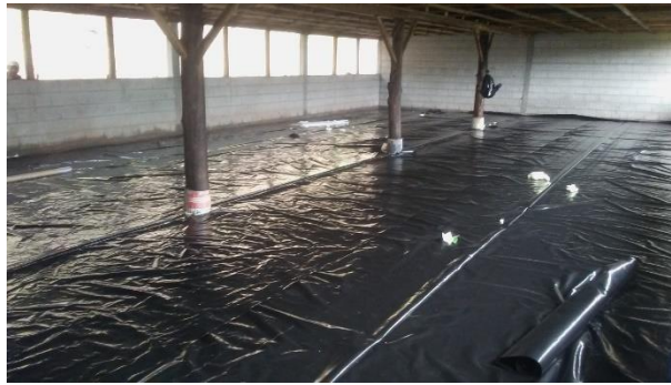
Figura A. 41. Proceso de fabricación piso radiante aislamiento [AUTOR].
