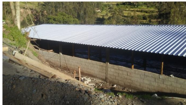
Figura A. 39 Galpón vista exterior [AUTOR].
