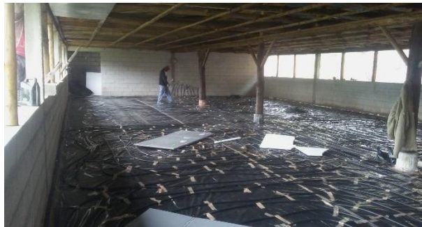
Figura A. 44 Proceso de fabricación piso entretecho [AUTOR].
