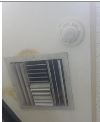
Figura 9: Fotografía detector de humo y rejilla de ventilación. Fuente: Autor
