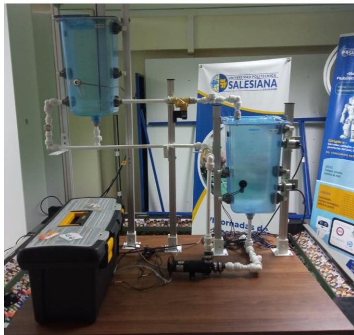
Figura 29. Planta instalada antes de pruebas
