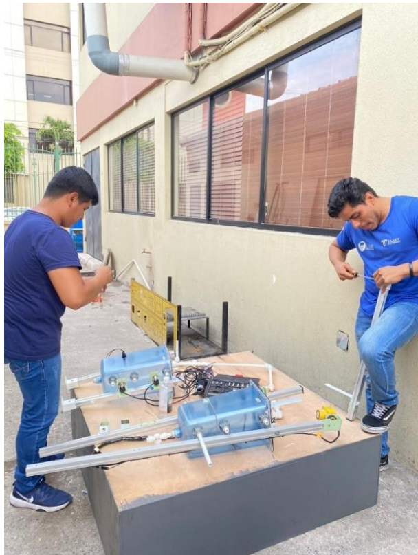
Figura 19. Desprendiendo bases de los pilares de planta.
