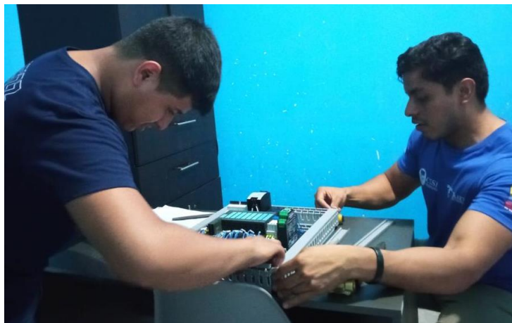
Figura 38. Montaje de equipos 2
