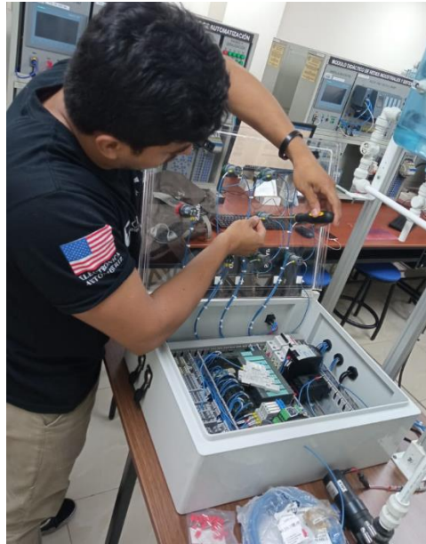
Figura 45. Cableado de alimentación de luces piloto
