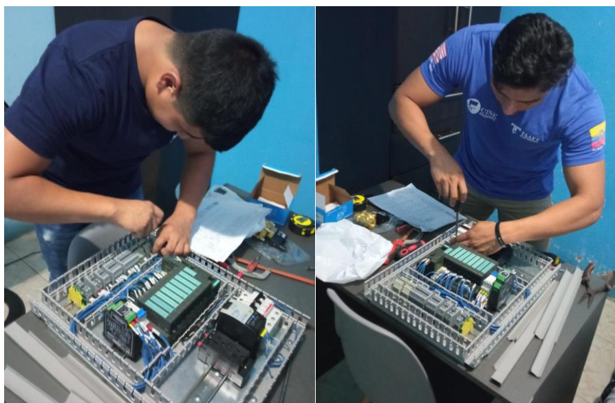
Figura 40. Colocación de marquillas y punteras
