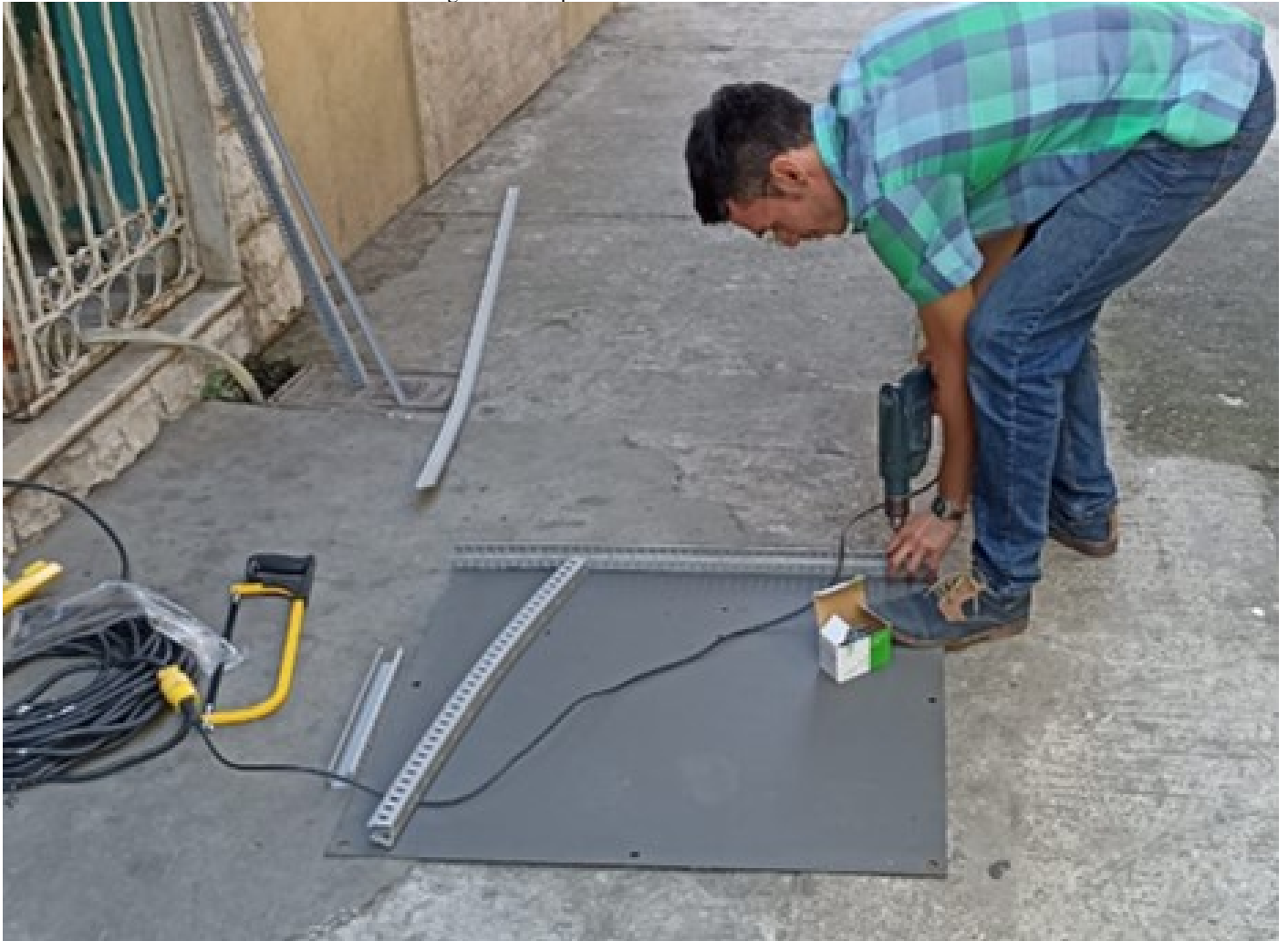
Figura 43. Implementando canaleta removible.
