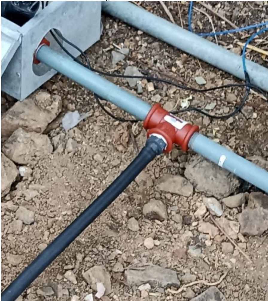
Figura 41. Implementación de tubería.
