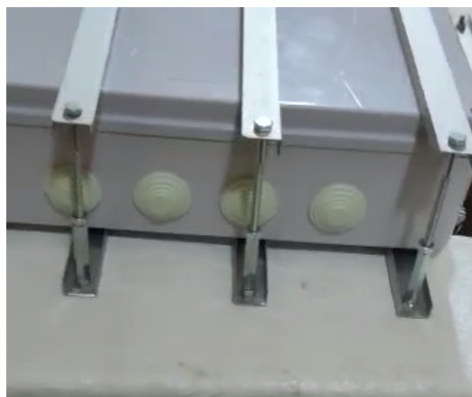
Figura 43. Ensamblaje entre soportes y caja de componentes, por A. Sánchez y L. Suárez
