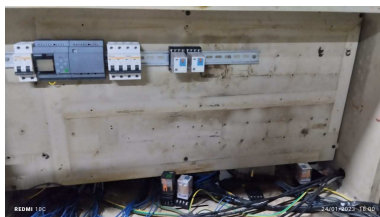
Figura 36. Colocación de componentes al riel DIN
