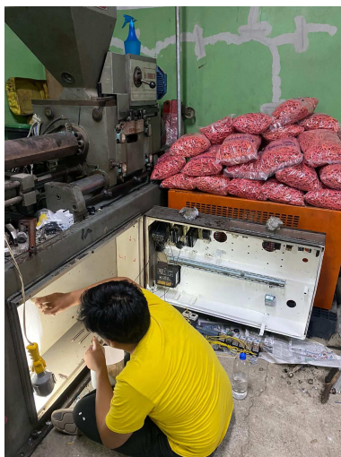
Figura 34. Pintado del panel de control para mejora visual y colocación de los nuevos componentes
