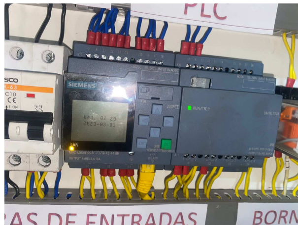
Figura 78. Conexión PLC
