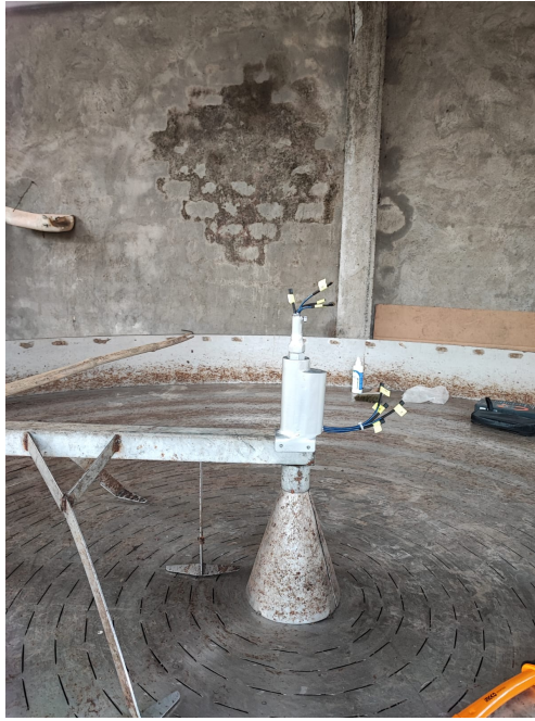
Figura 94. Instalación de anillos deslizantes [13]
