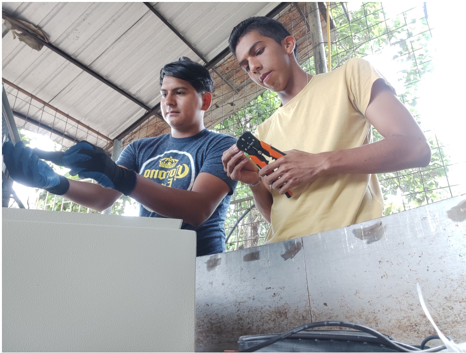
Figura 87. Preparando cables de señal [13]
