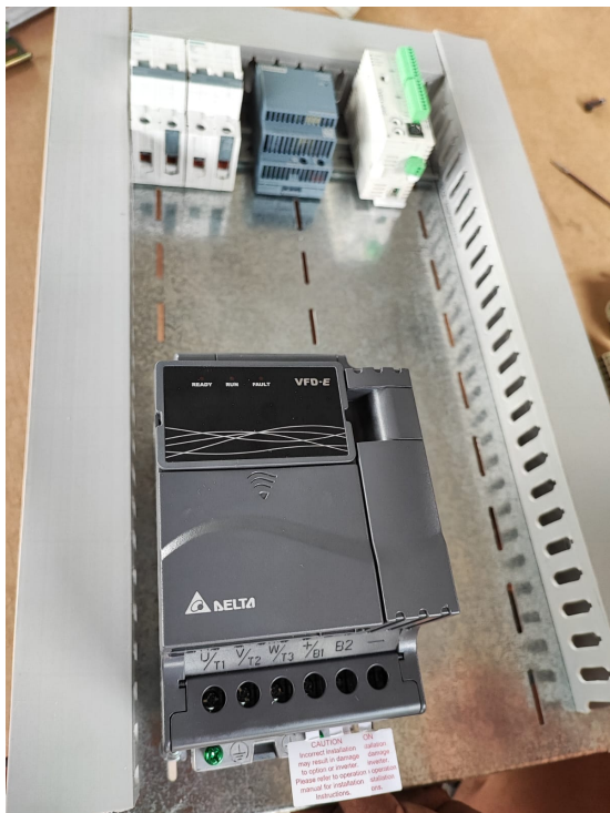
Figura 101. Montaje de variador [13]
