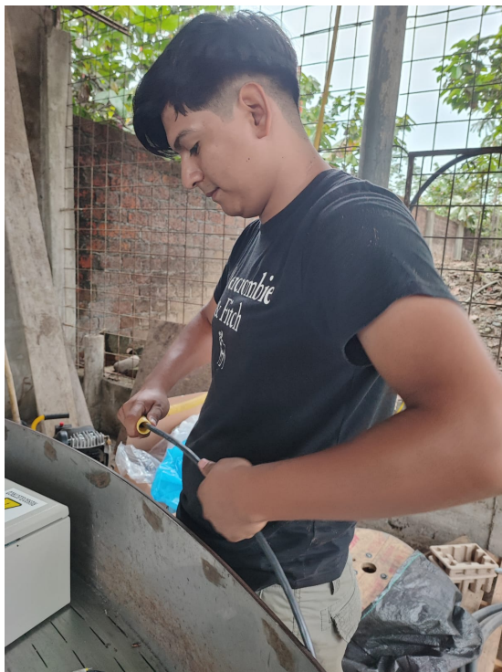
Figura 93. Pasado de cables eléctricos [13]
