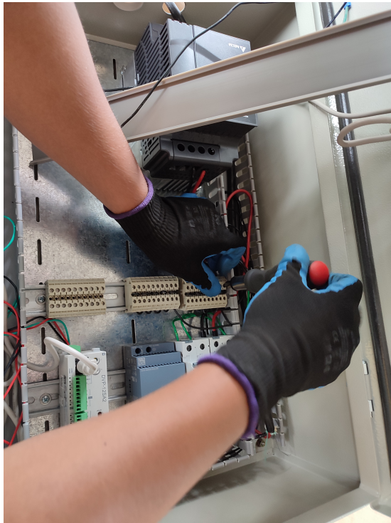
Figura 92. Montaje de borneras [13]
