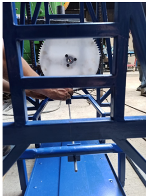
Figura 74. Construcción del prototipo
