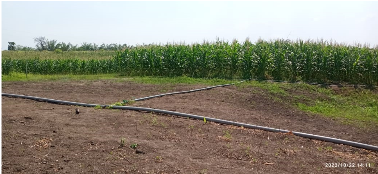
Figura 81. Implementación de Tuberías
