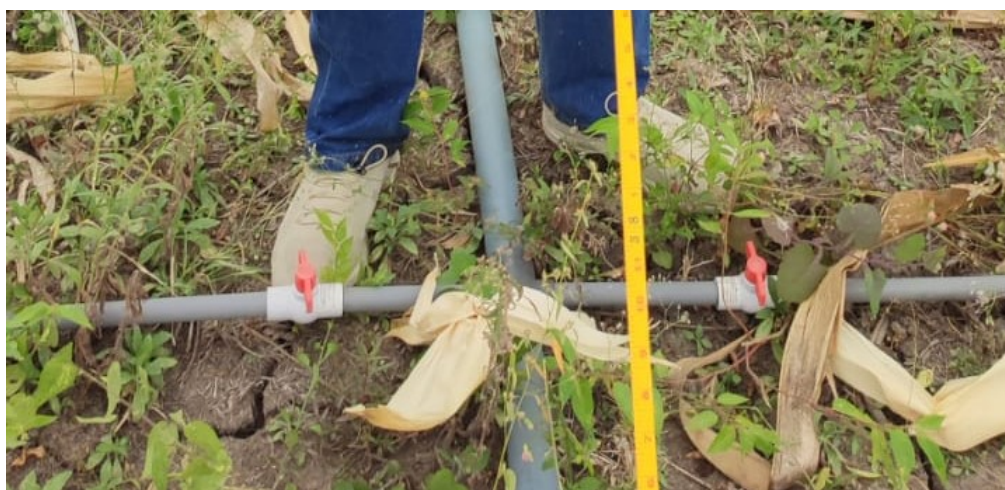
Figura 80. Implementación de las válvulas manuales tipo globo
