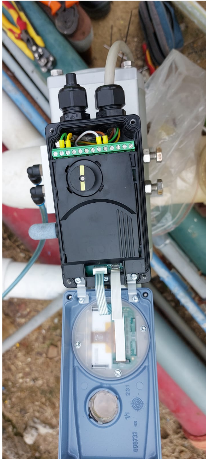
Figura 104: Calibración de válvula porcentual Fuente: Autor
