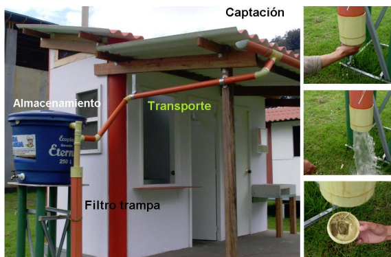
Figura 3. Captación de agua lluvia en el hogar Fuente: Hidropluviales
