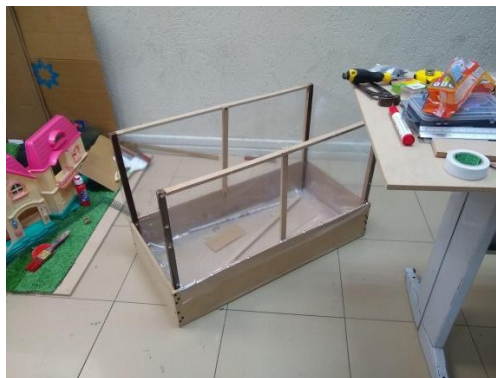
Figura 7. Armado de la estructura Fuente: Autores
