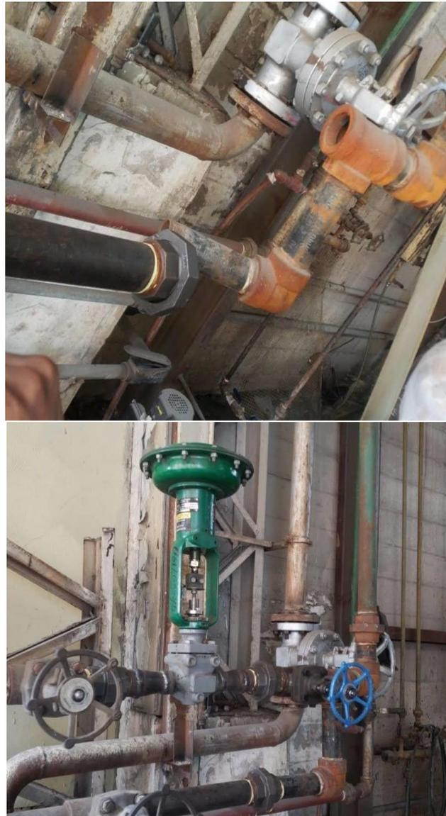
**Figura 73: Reemplazo de válvulas de seguridad**
