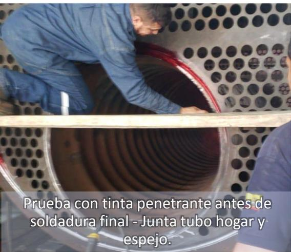
Prueba con tinta penetrante antes de soldadura final - Junta tubo hogar y espejo.
