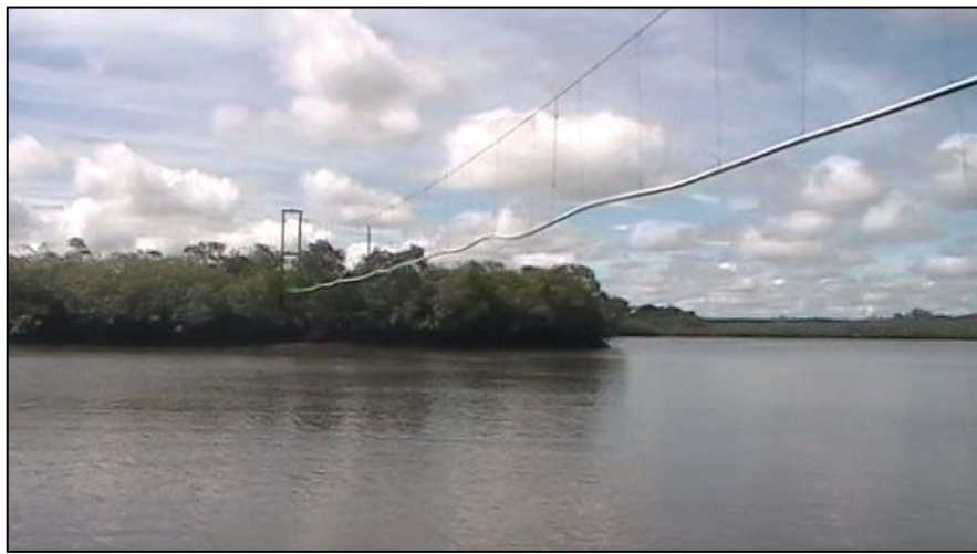
Figura 8. Cruce de la tubería de agua potable en el sitio propuesto para la implantación del puente.
