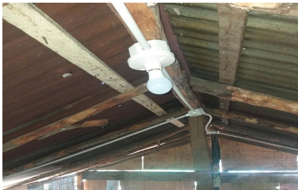
IMAGEN 33. Instalación Circuito alumbrado2
