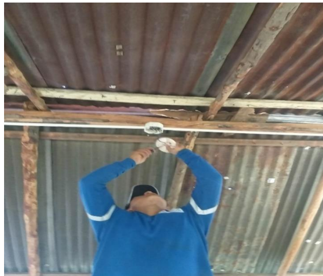
IMAGEN 24. Instalación luminaria.
