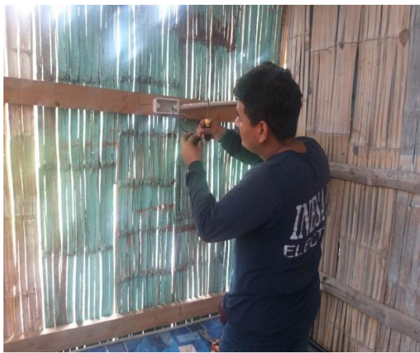
IMAGEN 28. Instalación toma corriente
