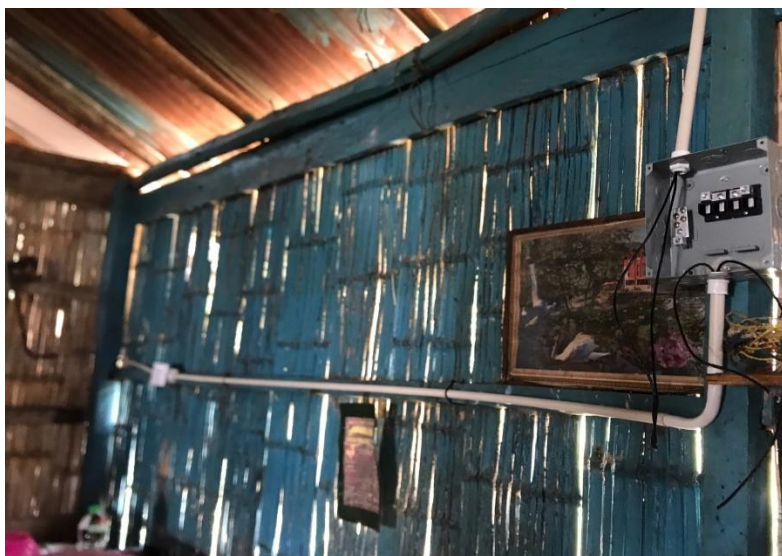
IMAGEN 31. Instalación Panel distribución
