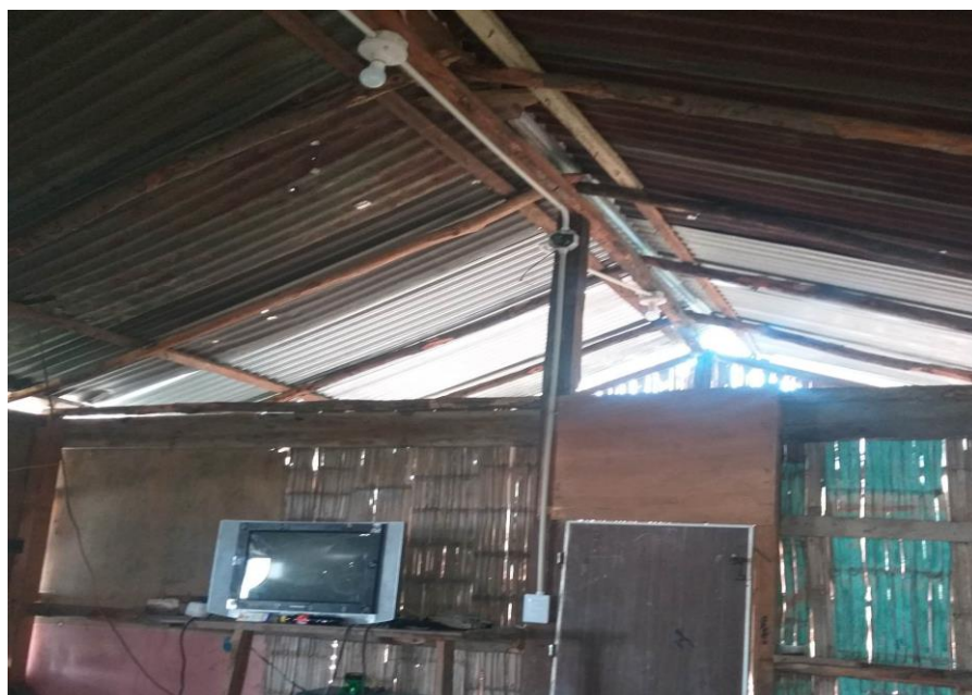
IMAGEN 32. Instalación Circuito alumbrado
