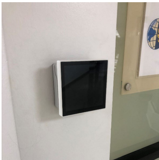
Figura 20. Pantalla de control touch instalado. Fuente: Autores.
