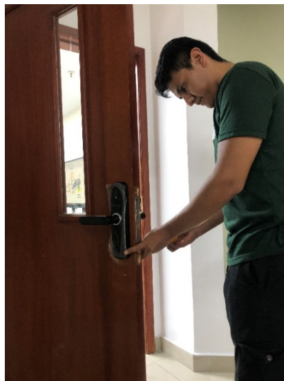
Figura 24. Proceso de instalación cerradura biométrica. Fuente: autores.
