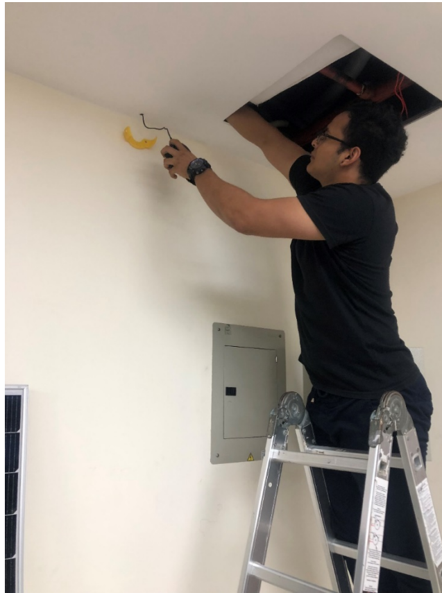
Figura 22. Proceso de instalación del altavoz Alexa. fuente: Autores.
