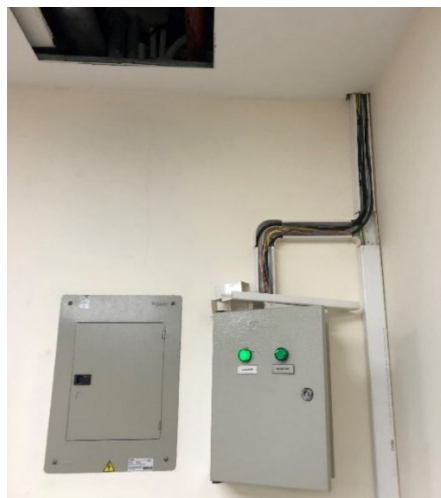
Figura 16. Instalación de cableado para medidores inteligentes; Fuente: autores.
