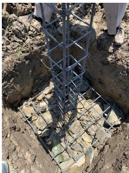
Figura 16 Estructura del poste del panel
