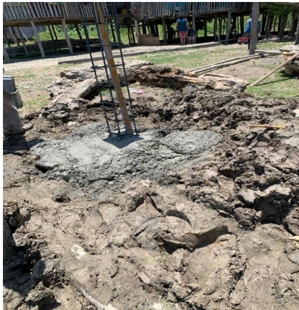
Figura 21 Relleno y instalación de la estructura de la base
