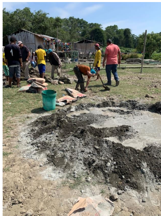
Figura 28 Relleno para la base del panel
