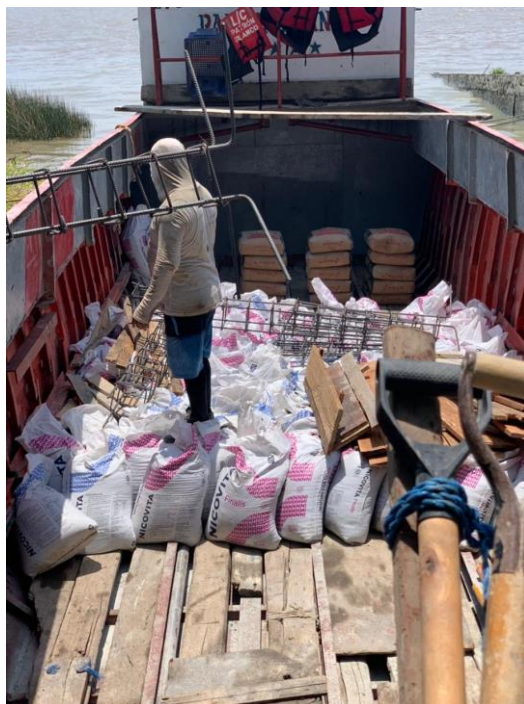
Figura 24 Traslado de materiales para la construcción de la base del panel
