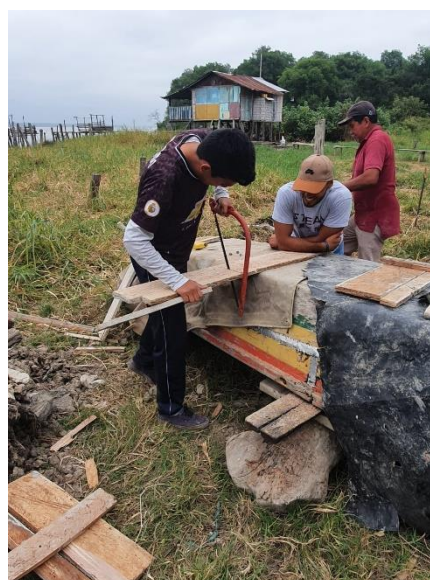
Figura 18 Estructura para el relleno de la base
