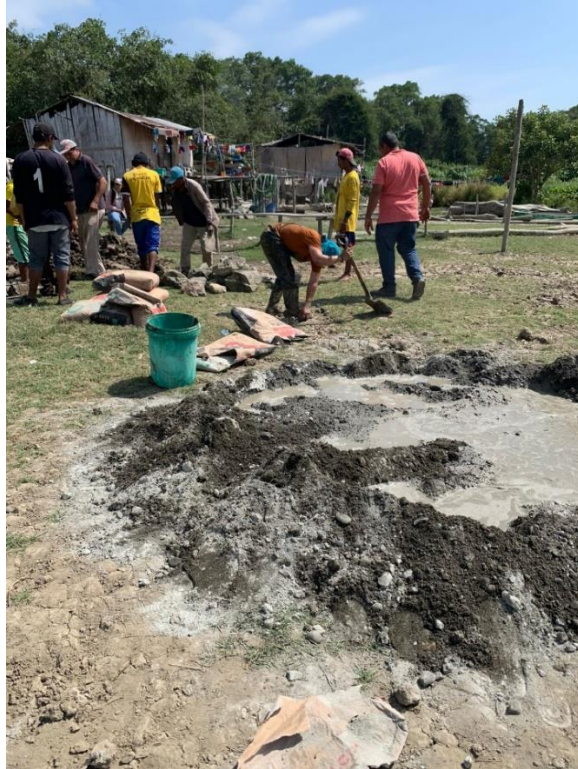
Figura 20 Preparación para el relleno de la base del panel
