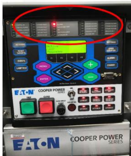
Ilustración 10. Recloser tipo Control form 6
