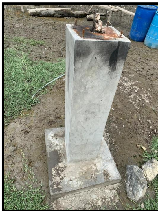
Anexo 11. Estructura "Plinto" del pilar
