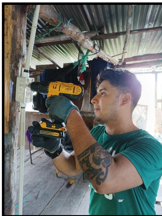
Anexo 14. Colocación de caja para interruptores
