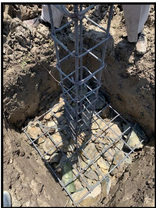
Anexo 11. Estructura "Plinto" del pilar
