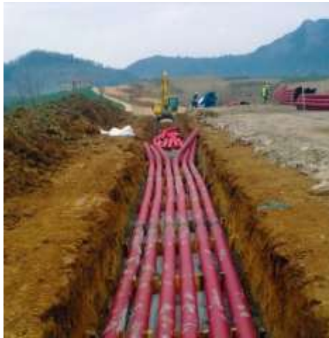
Figura 2.3 Red de distribución soterrada [36]
