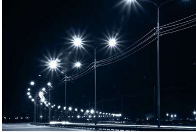
Figura 2.8 : Alumbrado público en vías [39]
