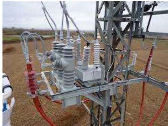
Figura 2.20 Equipo de protección de bajo voltaje [48]
