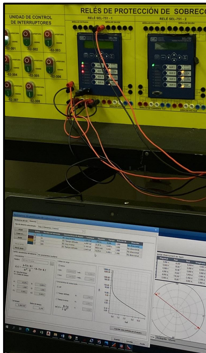
Figura 292: Configuración de Parámetros en el Test Universe para las pruebas de falla en el relé
