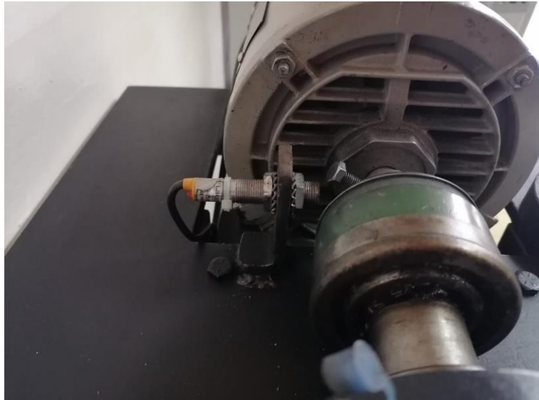
Figura 23. Sensor inductivo junto a elemento mecánico acoplado al motor.
