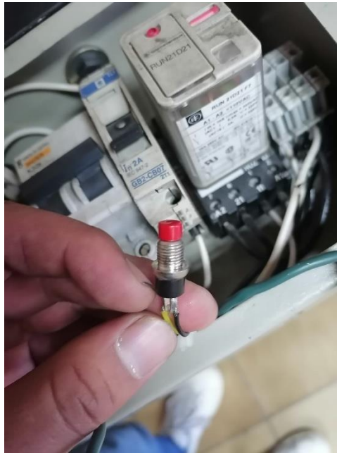
Figura 59. Pulsador adaptado al sistema de mando
