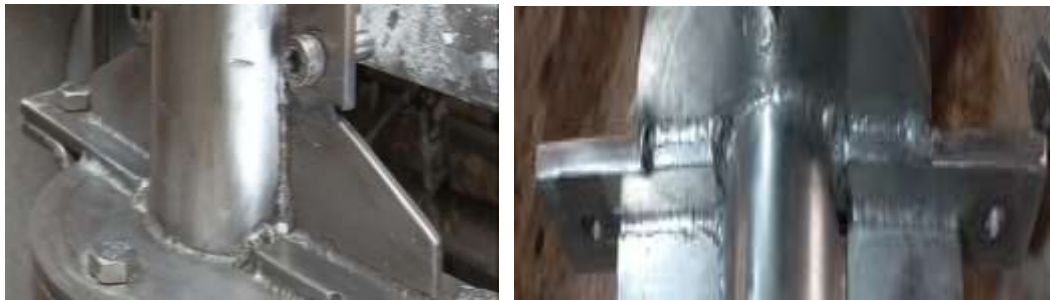
Figura 37. Base rectangular y bases pequeñas para la unión de los discos.
