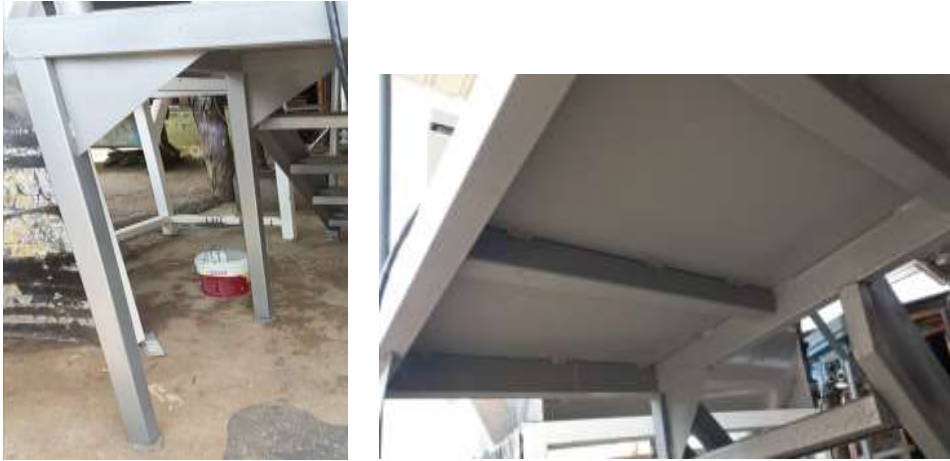
Figura 42. Soportes y pilares laterales para la base.
