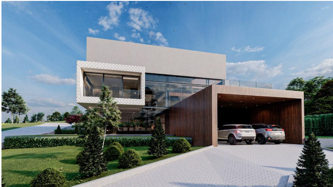
Ilustración 25 Parte frontal de la vivienda.
