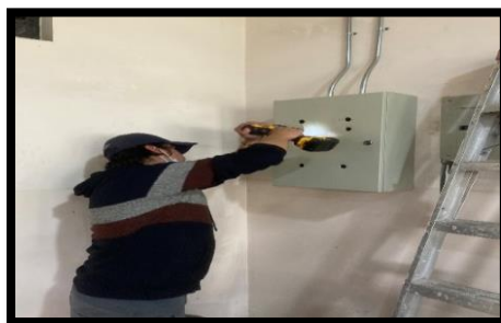
Figura 3.16: Instalación de tablero
