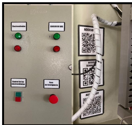
Figura 4.3: Resultados instalación del tablero
