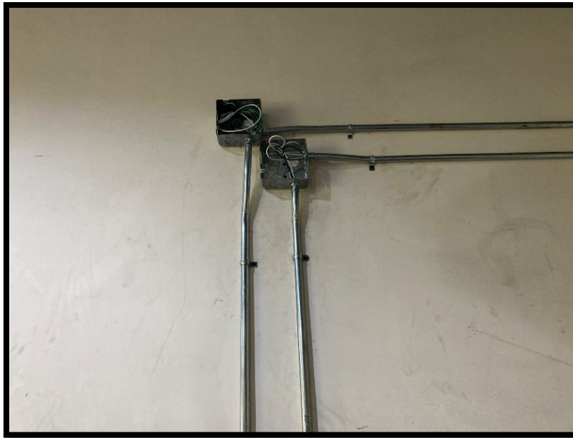
Figura 3.17: Instalación de canaletas metálicas
