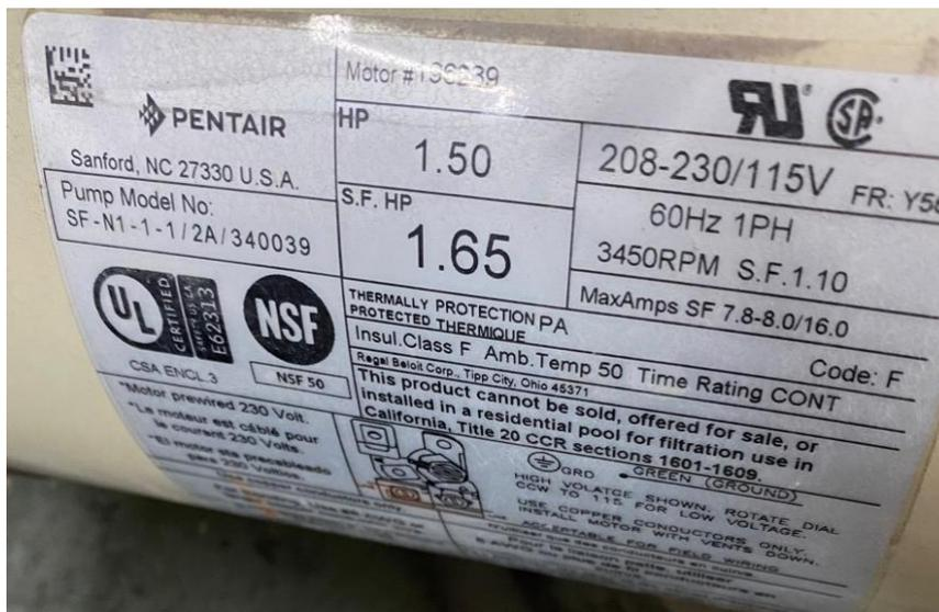
**Figura 34.** Placa técnica de la bomba que propulsa el agua de la piscina pequeña.
