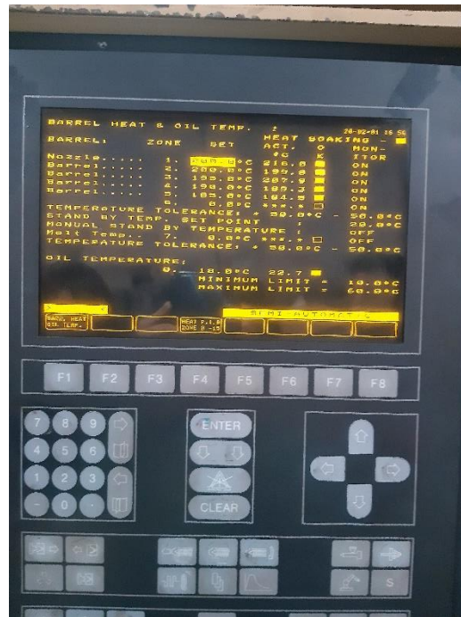
Figura 14 Panel eléctrico de la maquinaria
