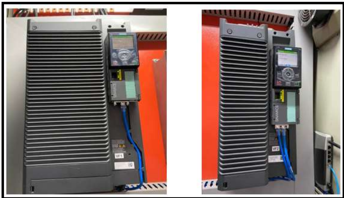
Figura 41 Variadores instalados.
