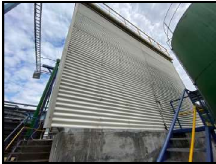
Figura 24 Exteriores laterales de la torre de mantenimiento.
