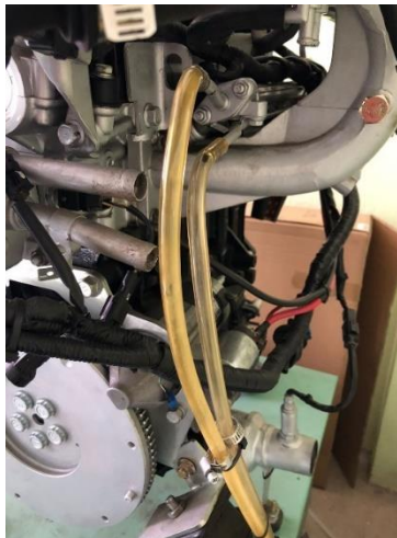
Ilustración 3-5 Cañería de baja presión.
