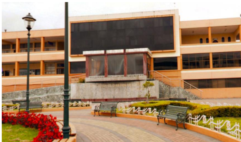
Ilustración 13. PUNTO 2: Edificio Cornelio Merchán
