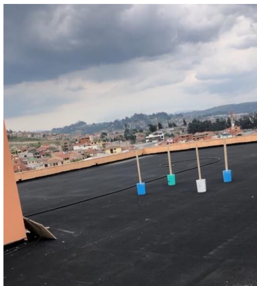
Ilustración 47. Vista panorámica del edificio a implementar la propuesta
