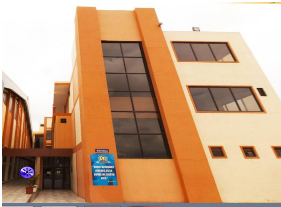
Ilustración 14. PUNTO 3: Edificio Biblioteca
