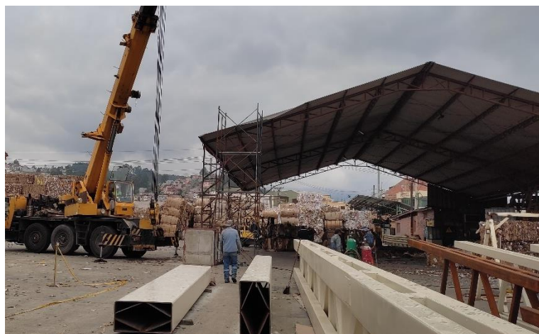
Figura 82 Montaje de cerchas. Fuente: Autores 2022
