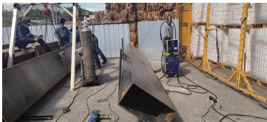
Figura 81 Construcción de columnas in situ. Fuente: Autores 2022
