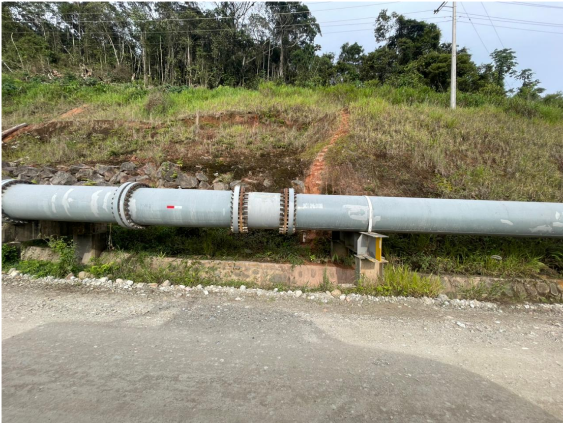
Ilustración 33. Fotografía del tramo identificado como punto crítico M4 de la tubería de descarga de relaves del proyecto Mirador.
