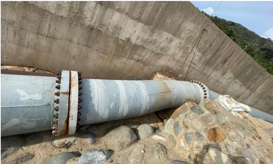
Ilustración 48. Fotografía del tramo identificado como punto crítico M14 de la tubería de descarga de relaves del proyecto Mirador.
