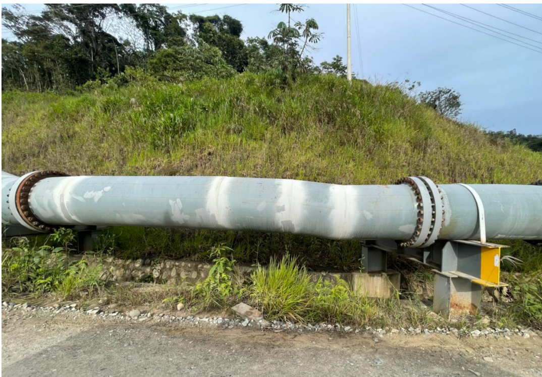
Ilustración 35. Fotografía del tramo identificado como punto crítico M5 de la tubería de descarga de relaves del proyecto Mirador.
