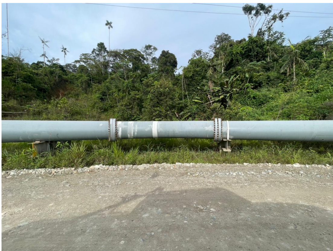
Ilustración 41. Imagen computarizada del punto crítico M9 de la tubería de descarga de relaves del proyecto Mirador.
