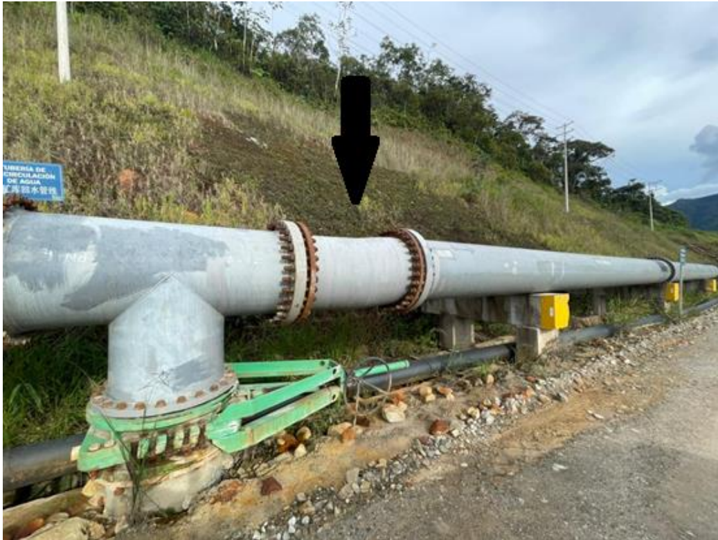
Ilustración 29. Fotografía del tramo identificado como punto crítico M2 de la tubería de descarga de relaves del proyecto Mirador.
