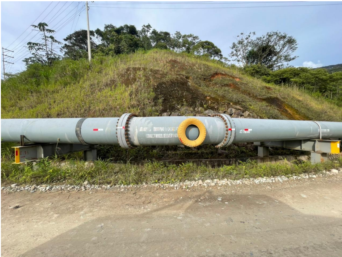
Ilustración 38. Fotografía del tramo identificado como punto crítico M7 de la tubería de descarga de relaves del proyecto Mirador.
