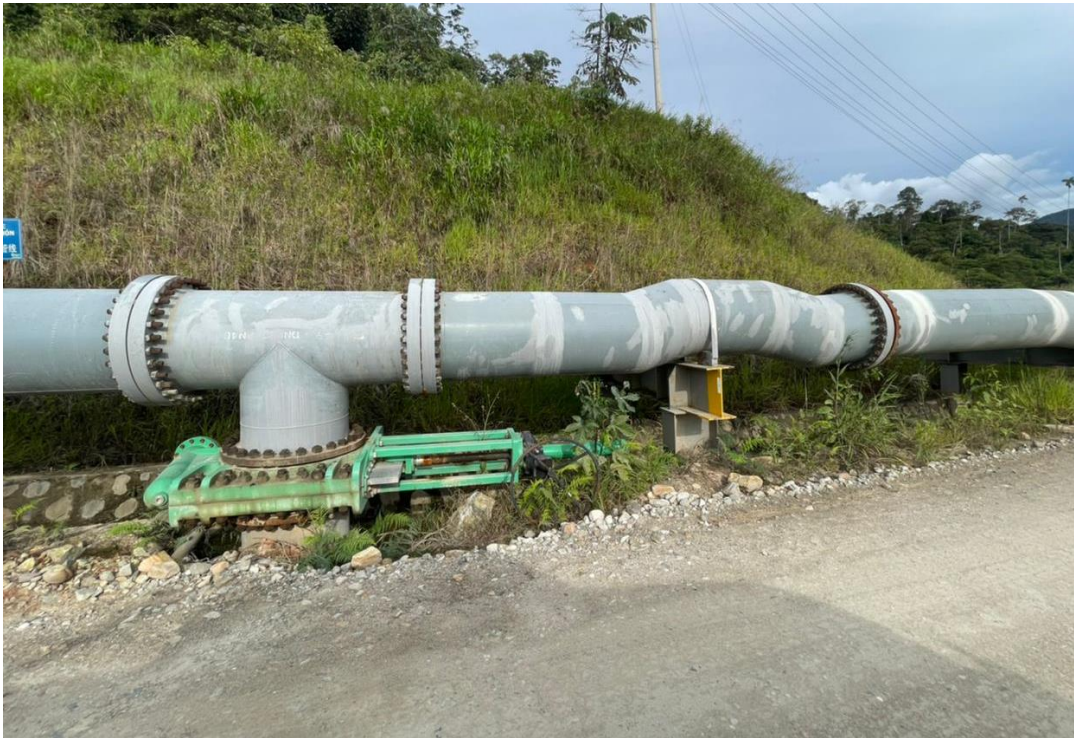
Ilustración 35. Fotografía del tramo identificado como punto crítico M5 de la tubería de descarga de relaves del proyecto Mirador.
