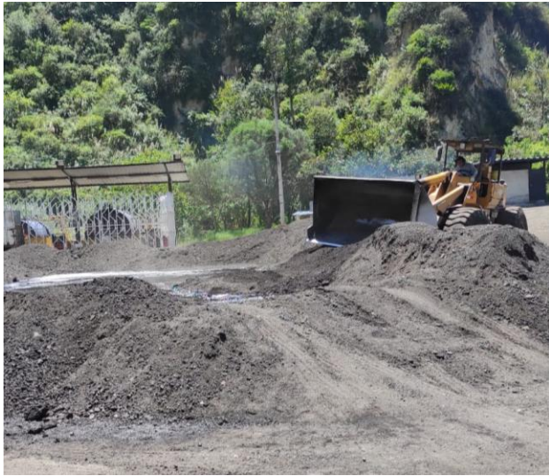
Figura 1: Montículos de material fresado, ubicados EPMOP
