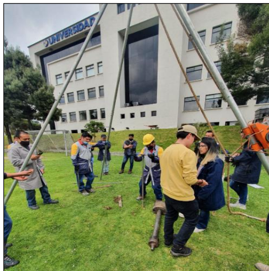
Limpieza de Terreno para SPT
