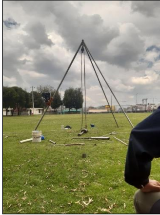
Montaje de Equipo
