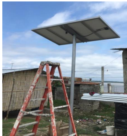
Ilustración 58 - Montaje del primer Panel Fuente: Autores
