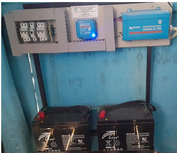
Ilustración 64 - Proyecto Finalizado Fuente: Autores
