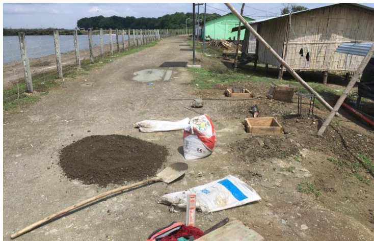
Ilustración 49 - Construcción de las bases de concreto Fuente: Autores
