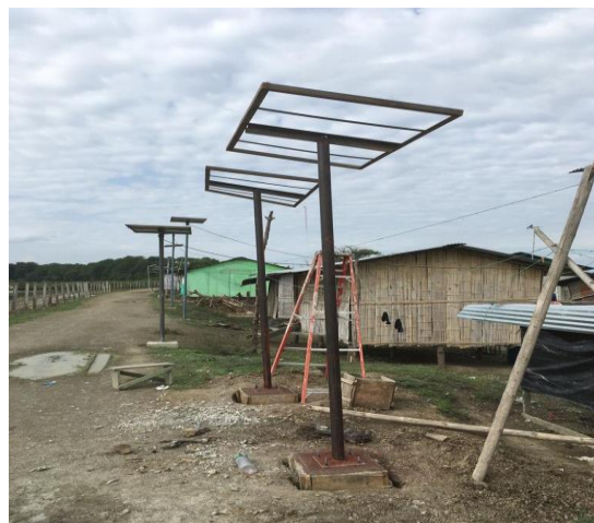
Ilustración 56 - Estructuras fotovoltaicas listas para pintar Fuente: Autores
