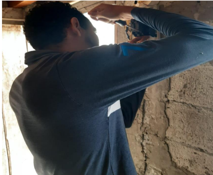
Ilustración 40 - Instalación panel de disyuntores Fuente: Autores
