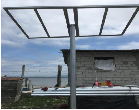
Ilustración 57 - Estructura fotovoltaica terminadas de pintar Fuente: Autores
