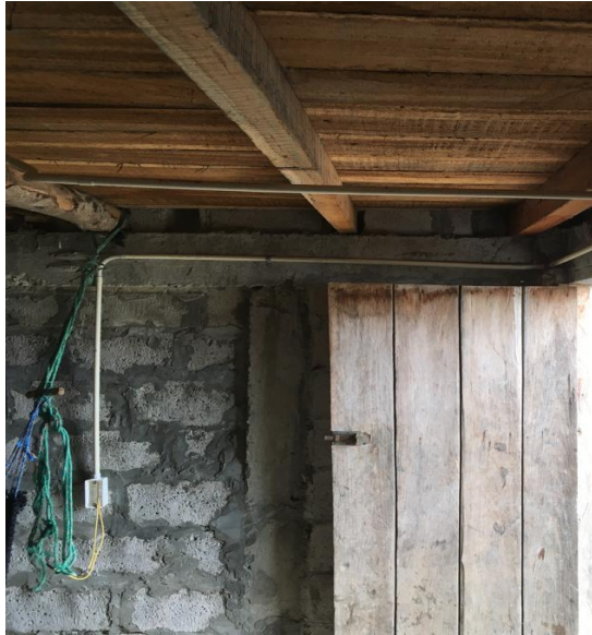
Ilustración 43 - Cableado eléctrico para circuito de tomacorrientes Fuente: Autores
