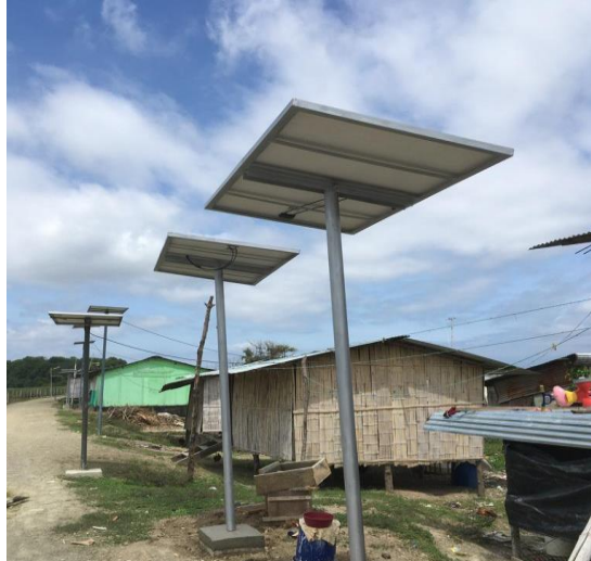
Ilustración 59 - Montaje del segundo Panel Fuente: Autores
