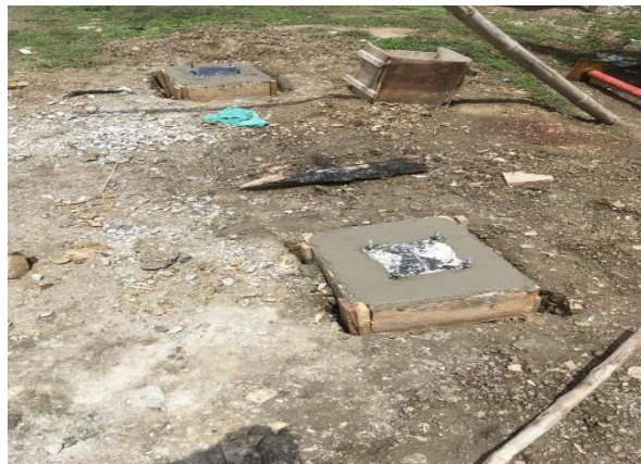
Ilustración 50 - Base de concretos fundidas Fuente: Autores
