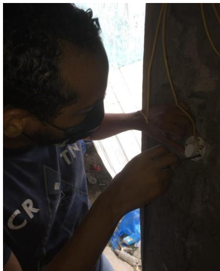
Ilustración 46 - Instalación de interruptores Fuente: Autores
