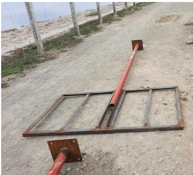
Ilustración 51 - Tubo y base para armar la estructura metálica Fuente: Autores
