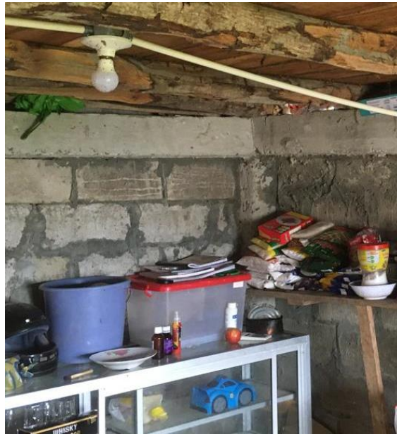
Ilustración 42 - Instalación de tubos donde pasan los cables para los circuitos Fuente: Autores
