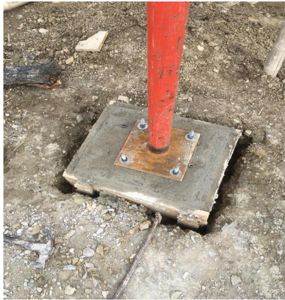
Ilustración 53 - Estructura metálica sobre la base de concreto Fuente: Autores
