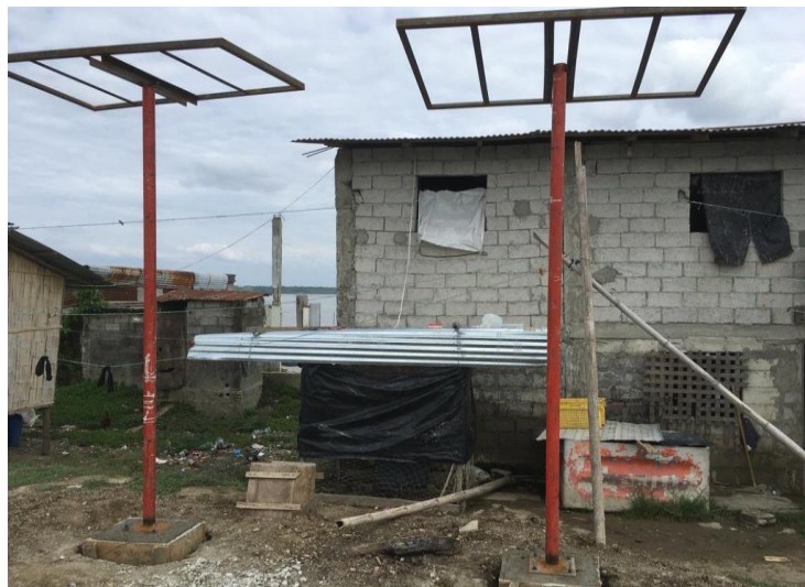
Ilustración 54 - Estructuras metálicas fotovoltaicas sobres las bases de concreto Fuente: Autores
