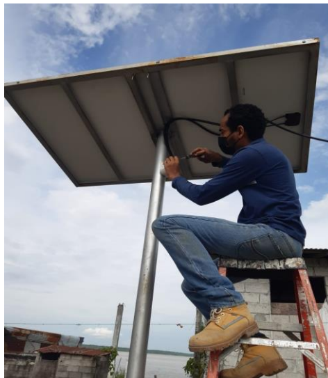
Ilustración 60 - Instalación de Paneles solares Fuente: Autores
