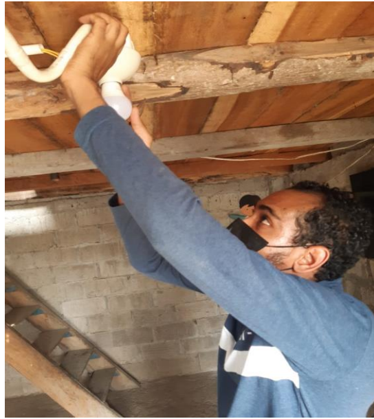
Ilustración 45 - Colocación de las boquillas y foco de las luminarias Fuente: Autores
