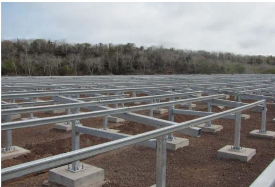
Ilustración 16 - Proyecto fotovoltaico puerto ayora en construcción Fuente: Plan maestro de electrificación 2013-2022
