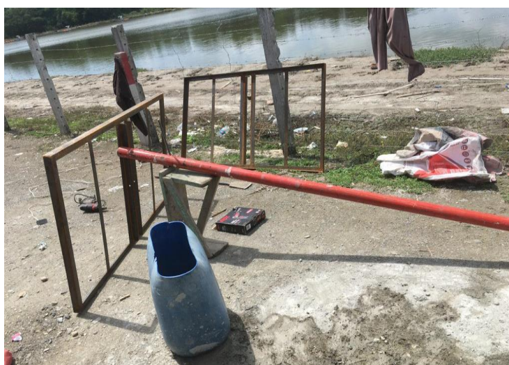
Ilustración 52 - Estructura Metálica Fuente: Autores
