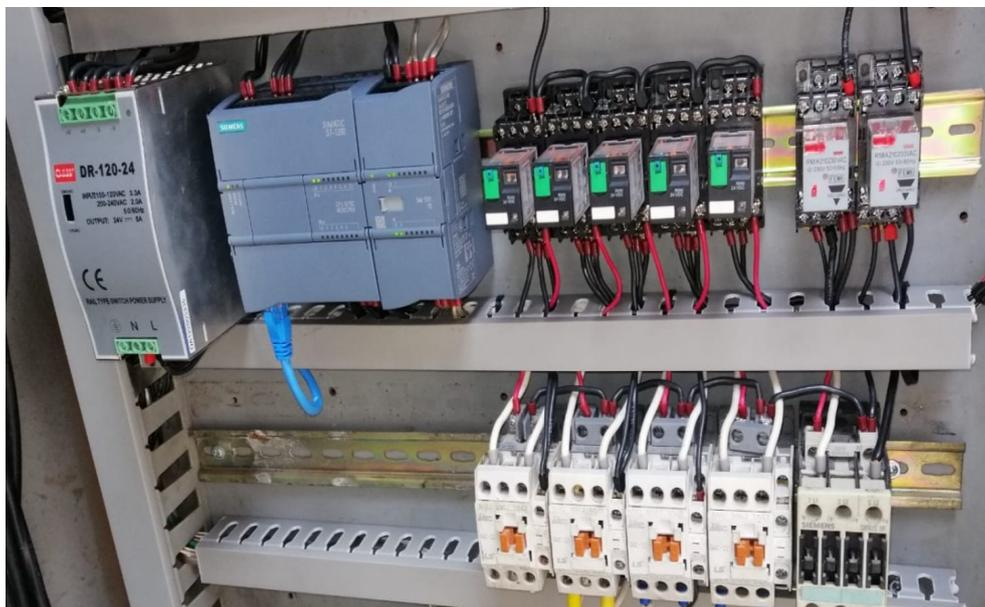
**Figura 27:** Disposición de fuente de poder - Plc S71200 - relés.
