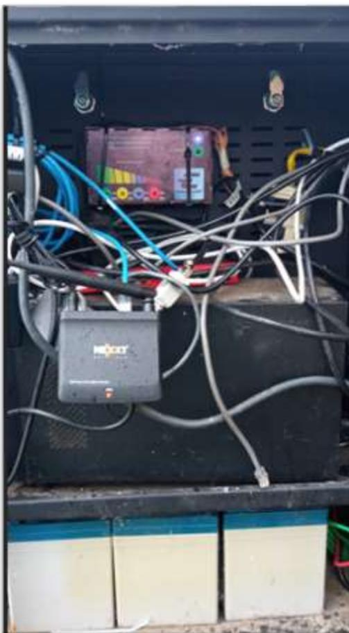
**Nota.** Conexión física del Banco de Baterías y Sensor Eléctrico al prototipo implementado en el nodo Escudo. Elaborado por: El Autor.
