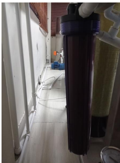
Figura A4. Filtro de polipropileno
