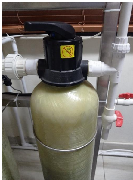
Figura A3. Filtro de carbón activado
