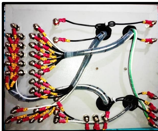
FIGURA 117: ADECUACIÓN, PEINADO Y MARQUILLADO
