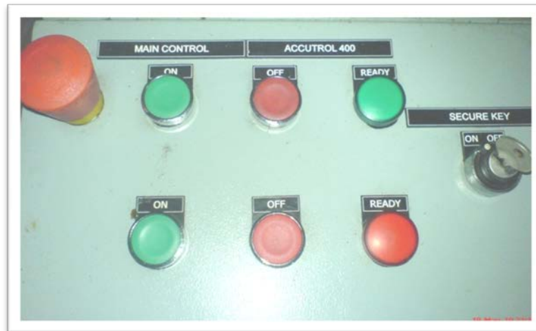
Gráfica 137: Foto de las botoneras de control en el panel frontal
