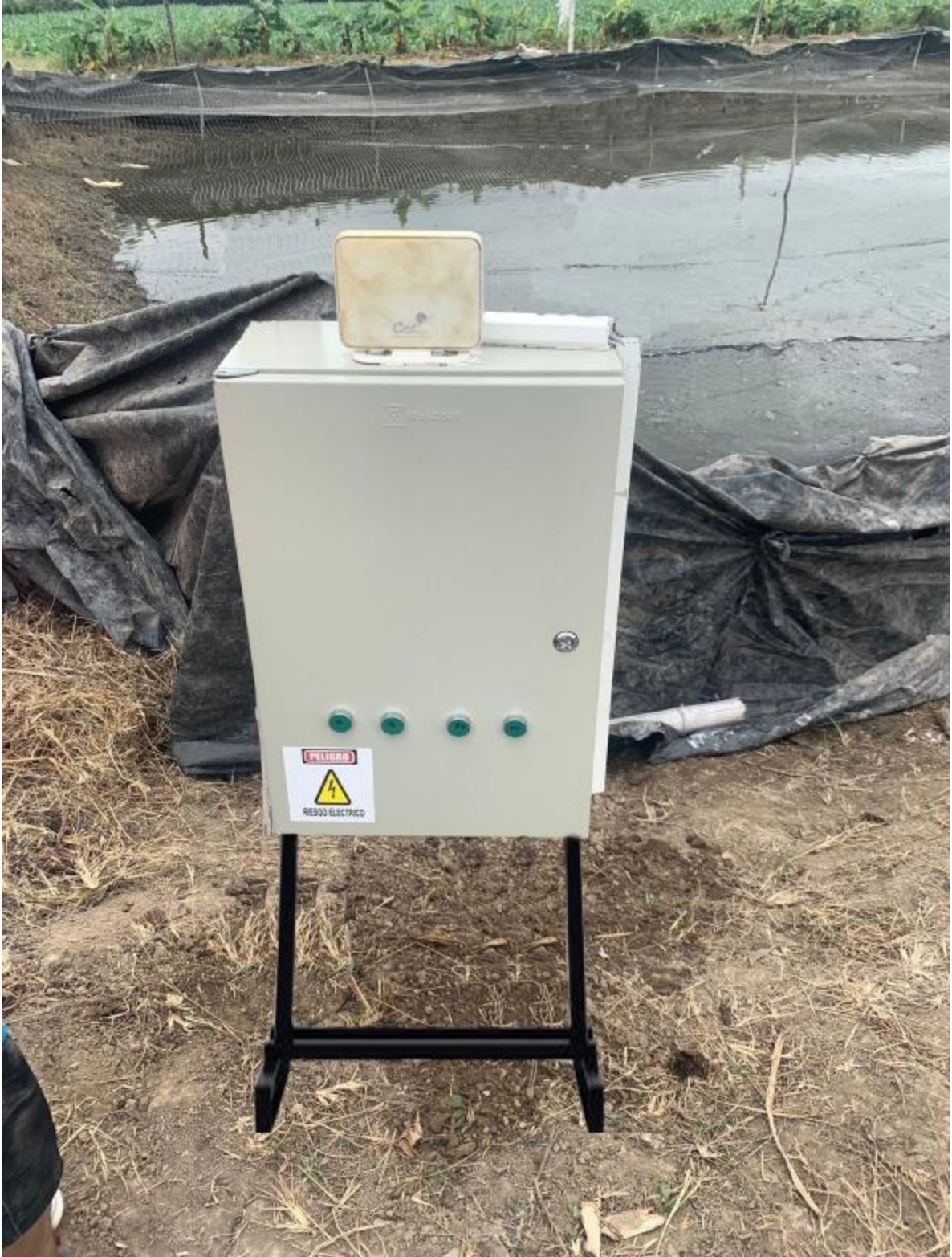
Figura: Montaje del tablero en la zona del recinto
