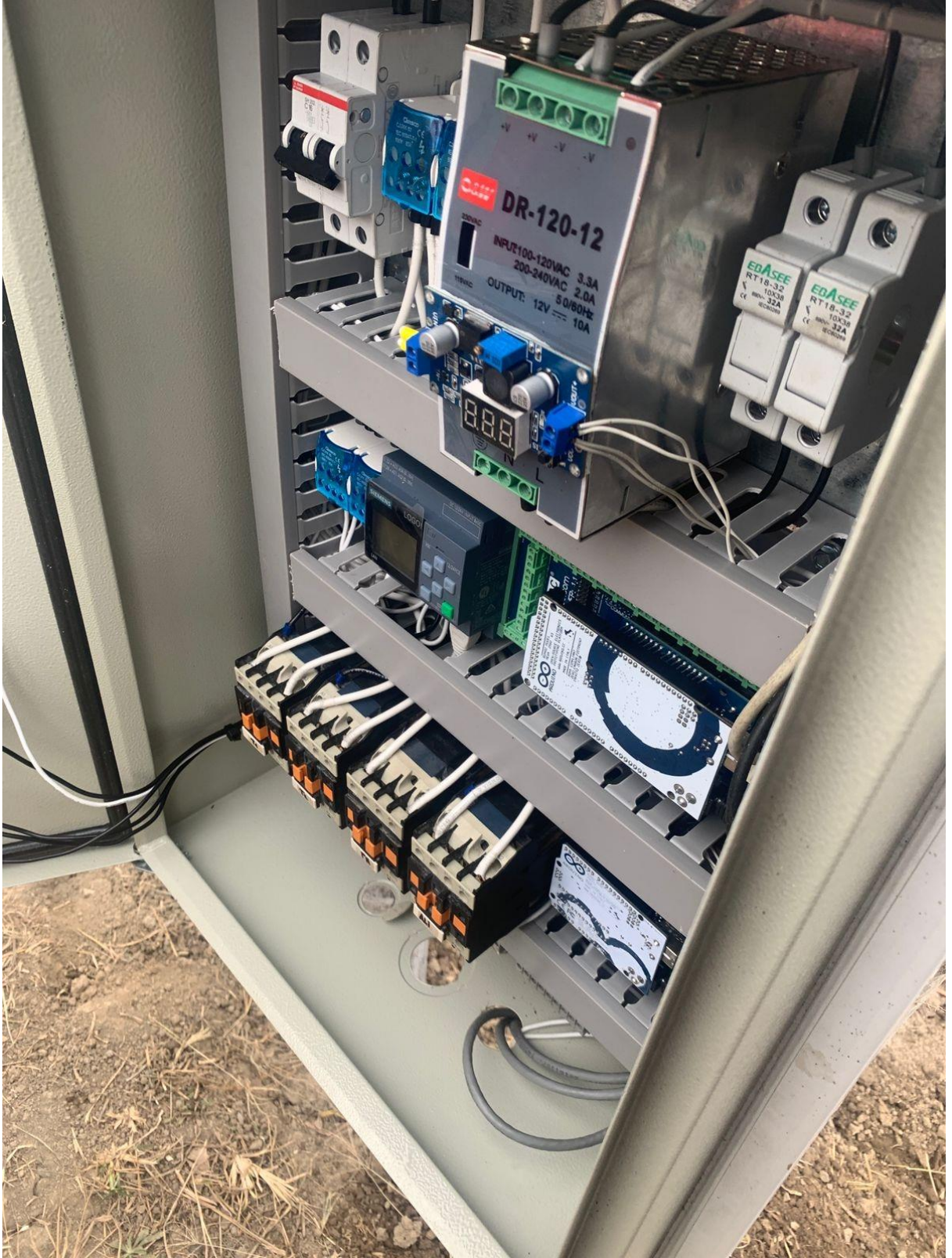
Figura: Tablero posicionado en el lugar del recinto
