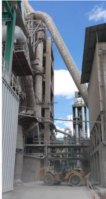
**Fig. 30.** Tubería referencial del proceso que conduce el gas residual del horno rotatorio al filtro de mangas [3].
