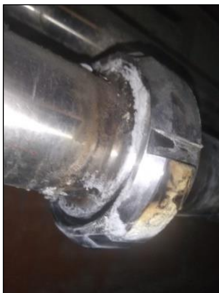
Figura 17: Uniones de tubería INOX en remplazo de tubería de acero negro.
