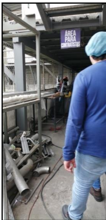
Figura 16: Área para contratistas tomando medidas y soldando tubería INOX
